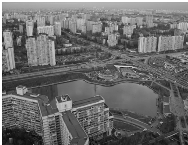
Рис.1 Жилой дом на пересечении Балаклавского проспекта и Чертановской улицы (микрорайон Северное Чертаново, г. Москва)
