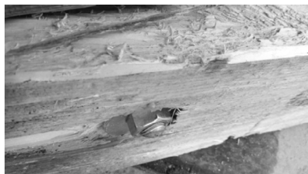
Рис. 14. Наклонные винты в нижней части.
