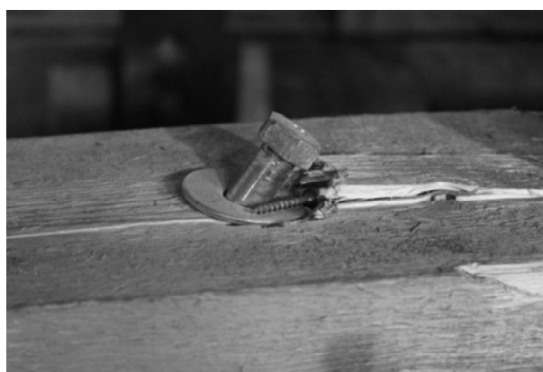
Рис. 13. Наклонные винты в верхней части.
